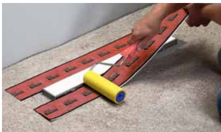
Шаг 3 – Наклеивание гидроизоляционной манжеты Seal System
