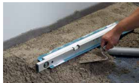
Шаг 2 – Укладка бетонной стяжки
