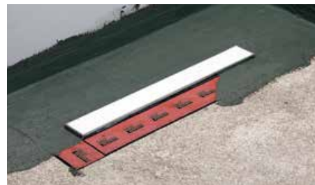
Шаг 4 – Нанесение гидроизоляционного слоя
