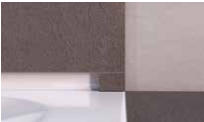
Позади душевой перегородки вставляется кусочек плитки, закрывающий полость
